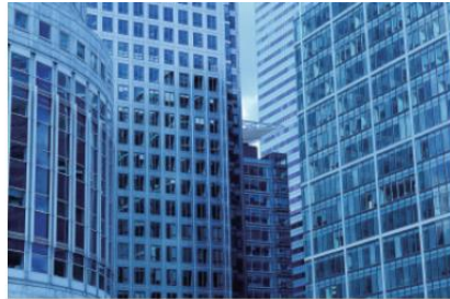
■商業ビル、オフィスの出入口
